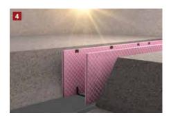
Die Fundamentschalung wird auf die **Sauberkeitsschicht** im Fundamentgraben gestellt.
