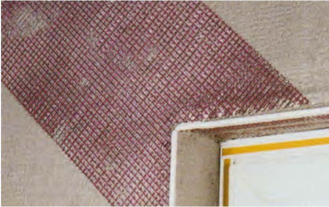
Bild 7: Armierungspfeil an Öffnungsecken
