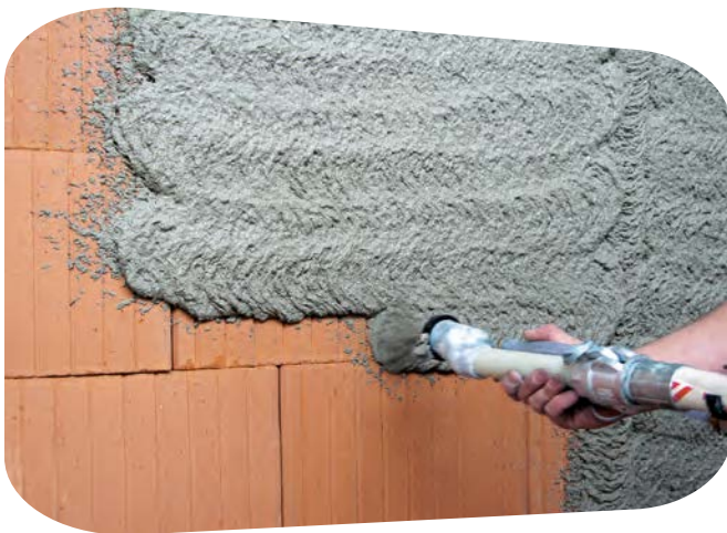
Bild 13: Auftrag des Unterputzes auf Planziegelmauerwerk
