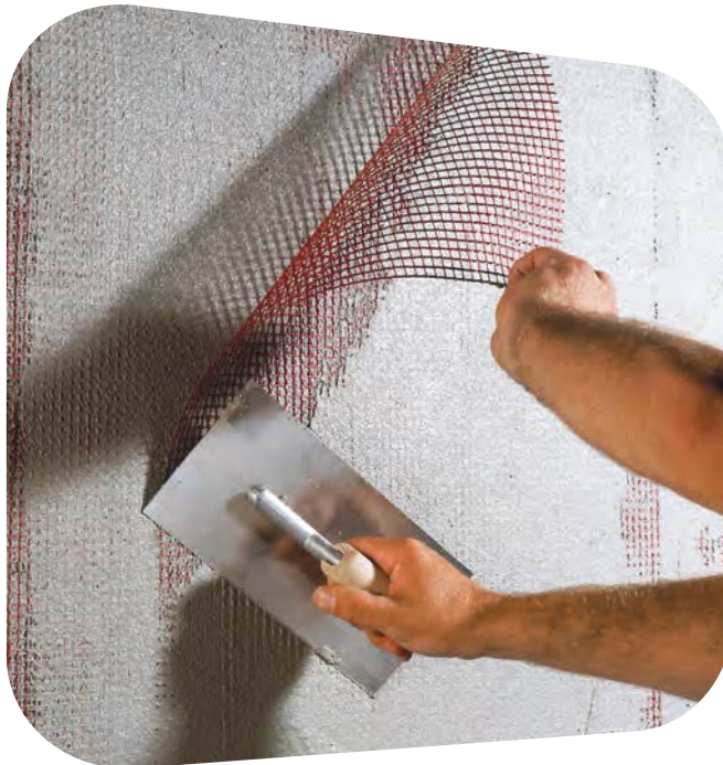
Bild 8: Armierungsputz mit Gewebeeinlage
