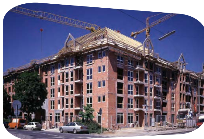
Bild 1 und 2: Homogenes Ziegelmauerwerk
