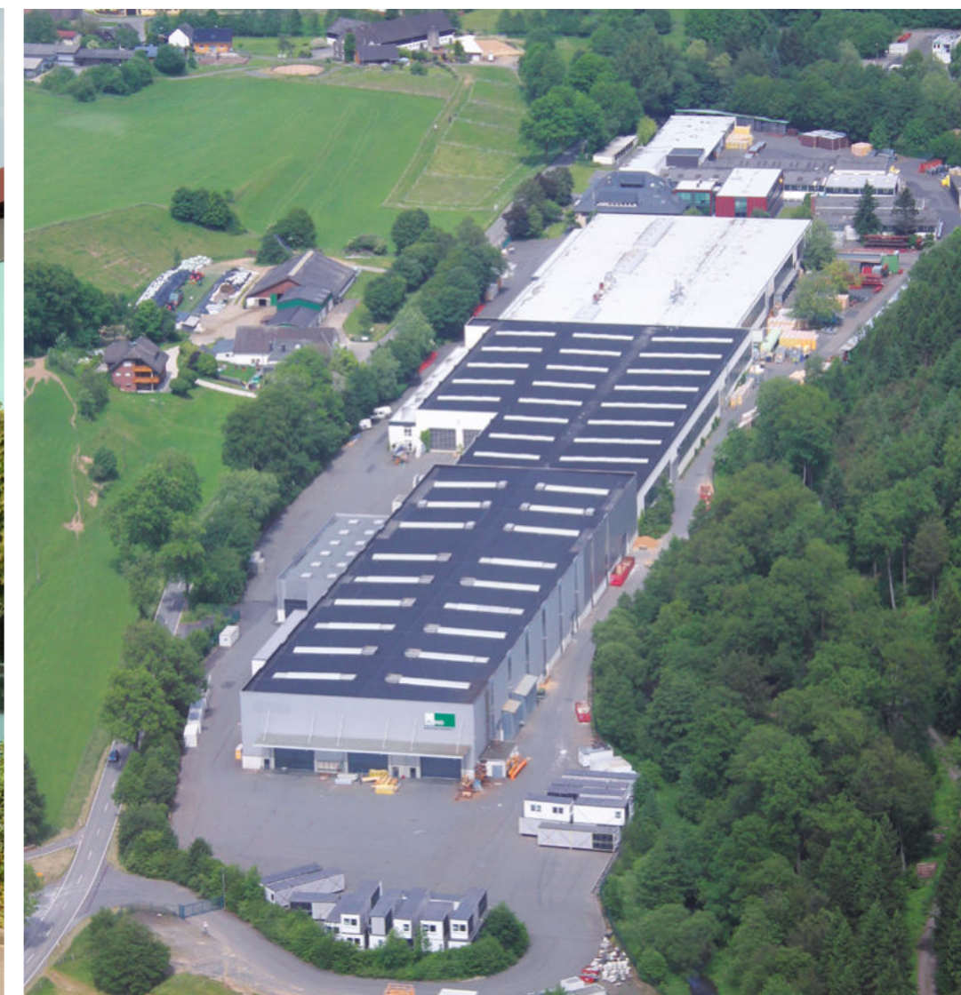
Verwaltungsgebäude und Produktion von ALHO am Standort Morsbach
