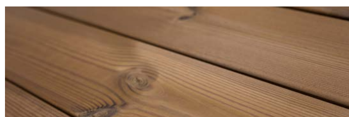
Ungeölte Thermory Benchmark Thermo-Kiefer Terrasse nach der Verlegung
