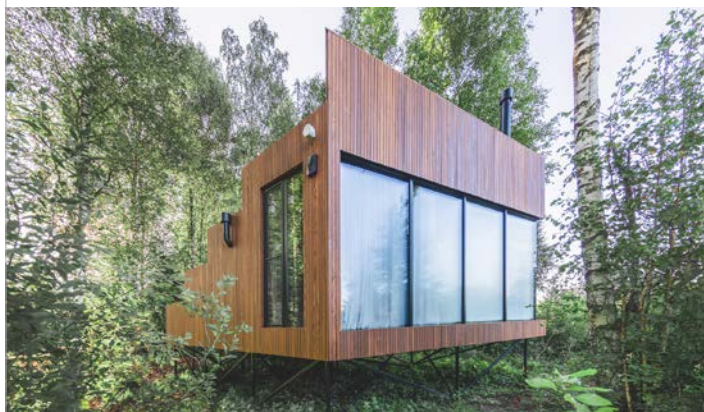
Thermory Benchmark Thermo-Esche-Fassade einige Monate nach der Montage. Maidla Nature Resort in Estland Foto: Elvo Jakobson
