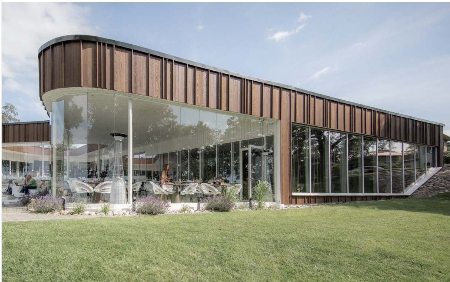
Thermory-Benchmark-Fassade aus ölbehandelter Thermo-Esche. Restaurant NOA in Estland Foto: Elvo Jakobson
