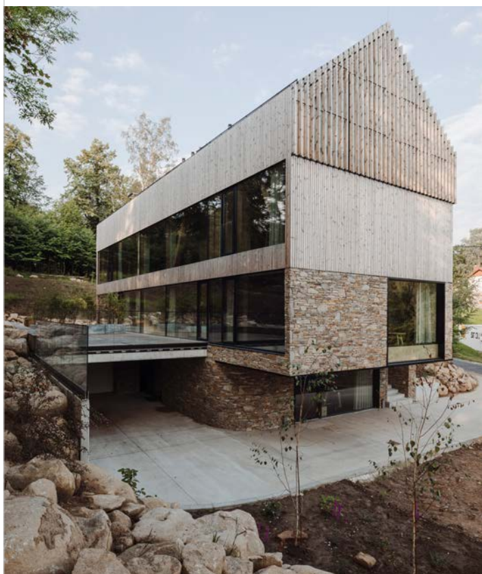
Ungeölte Benchmark Thermo-Kiefer-Verkleidung ein Jahr nach dem Anbringen Wohnungen in Polen Foto und Vertrieb: Komplex Market
