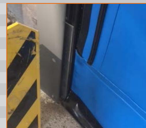
Führungsschiene mit Zip-System und Flex-Edge-Schließkante
