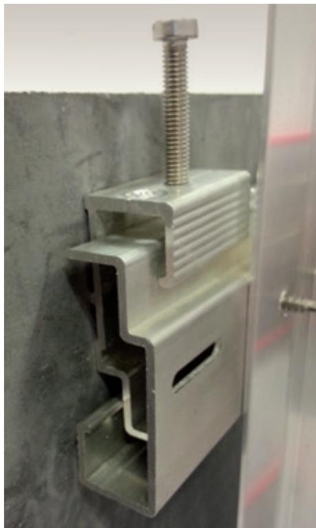
Die Struktur besteht aus Profilen und Klemmen. Diese Klemmen werden mit korrekt bemessenen Dübeln an dem bestehenden Stützelement befestigt. Anschließend werden die horizontalen Profile an den Mittelpfosten befestigt. Die **DEKTON**-Platten werden an diesen horizontalen Profilen aufgehängt.
