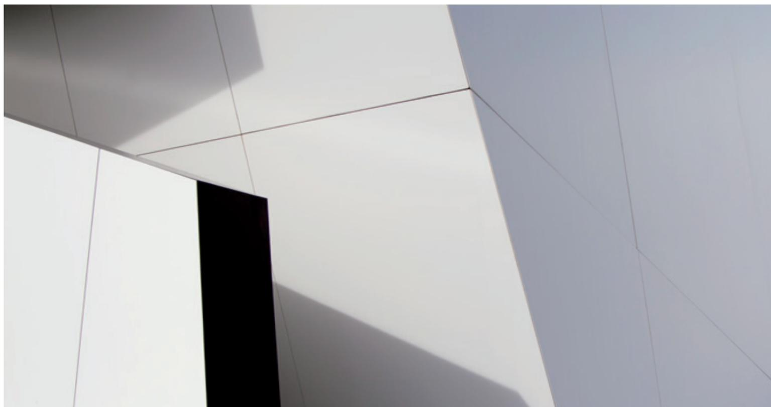
Hinterlüftete Fassaden stellen eine leistungsstarke bauliche Lösung zur Verkleidung von Gebäuden dar, bei der das Verkleidungsmaterial mit mechanischen Verankerungselementen und einer Metallstruktur am Gebäude befestigt wird.
