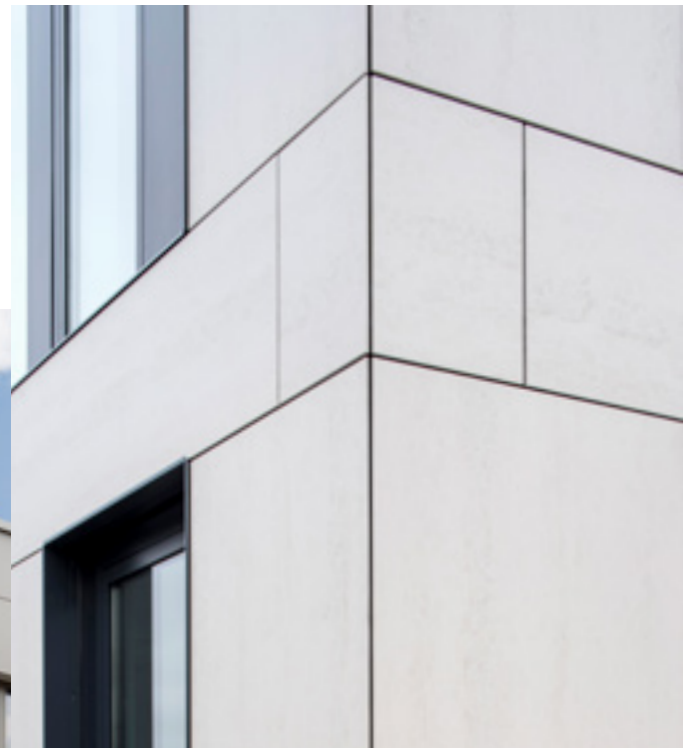
Schittenhelm Büro gebäude. Deutschland.
