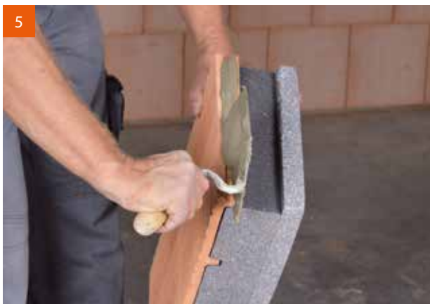
Auftrag Dünnbettmörtel auf die Stoßfuge.
