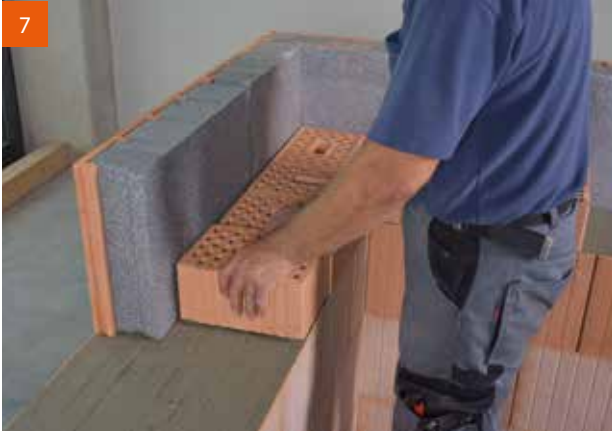
7 Alternativ: Höhenausgleich mit kleinformatigen Ziegeln.
