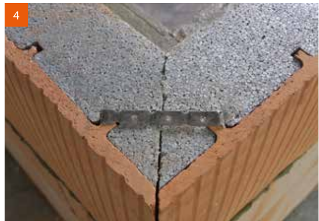
Gegebenenfalls Montageunterstützung mit Flachstahlanker über Eck.
