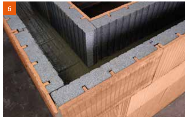
6 Fertige Ringbalkenschalung aus DS vario im Eckbereich.
