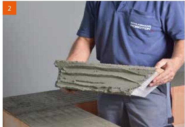
Satter Mörtelauftrag auf POROTON®-DRS®.
