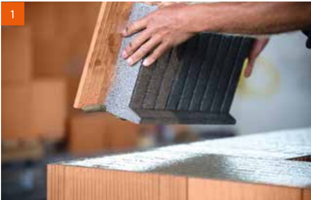
1 Verklebung mit Dünnbettmörtel oder ...
