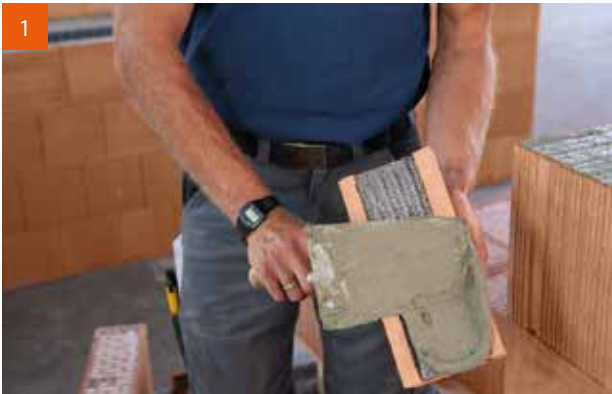
Anmörteln der Anschlagschale.
