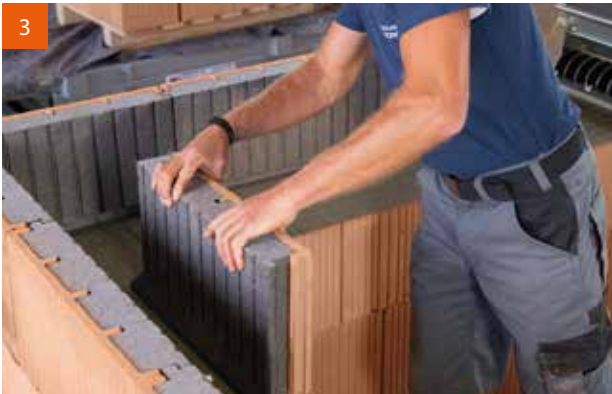
3 Setzen der Ringbalkenschalung.
