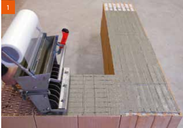
Auftrag des Dünnbettmörtels auf die Mauerkrone.
