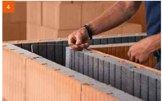
4 DS vario Montagebügel zur Lagesicherung einsetzen.
