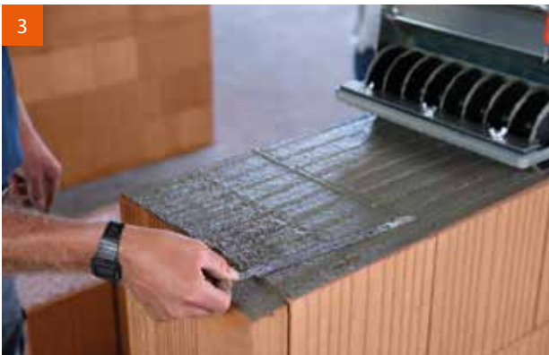
Ggf. zusätzliche Lagesicherung mit Flachstahlanker.
