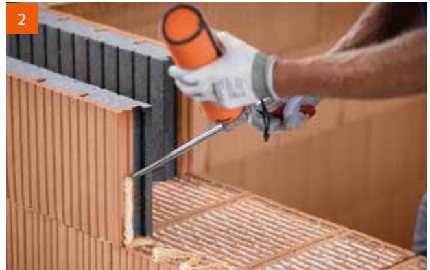
2 ... PU-Montagekleber (z. B. Dryfix).
