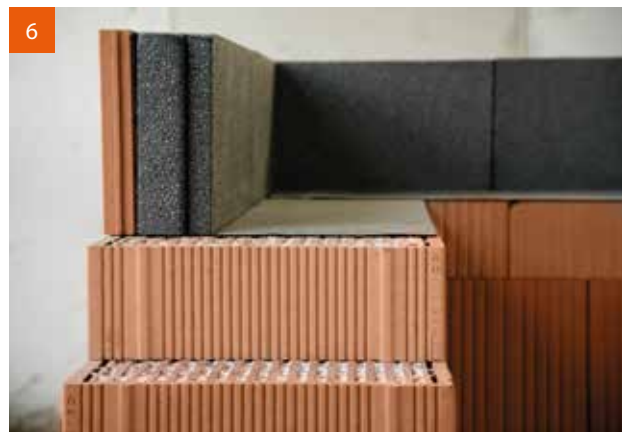
Deckenrandschale auf Höhenausgleichsziegel POROTON®-HAZ.
