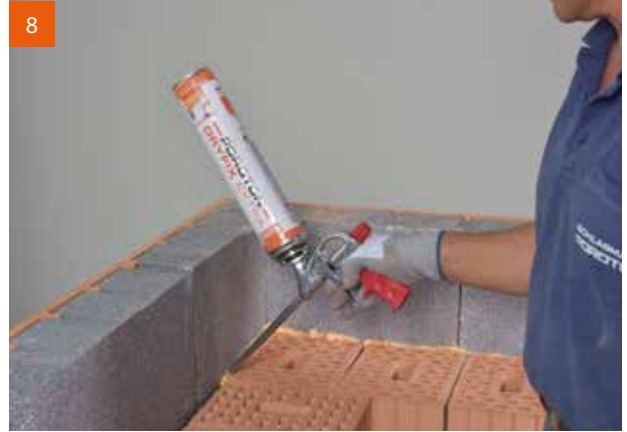
8 Bei sehr hohen Deckenrandschalen wird empfohlen, zusätzlich mit dem kleinformatigen Ziegel zu verkleben (z. B. mit Dryfix).
