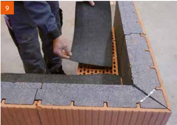
9 Trennlage (z. B. R500) auf Mauerkrone auslegen.
