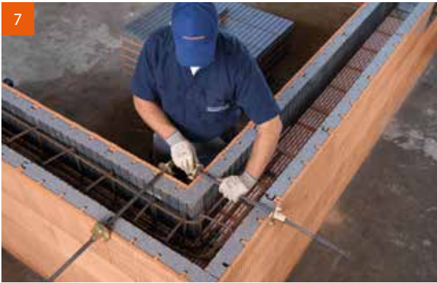
Schalungsanker zur Sicherung gegen Betondruck anbringen.
