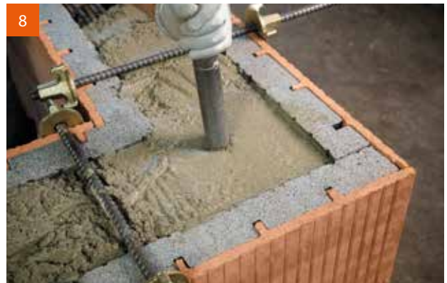
Ausbetonieren des Ringbalkens und Verdichten des Betons.
