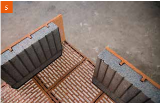
5 Ausklinkung im Eckbereich erstellen.
