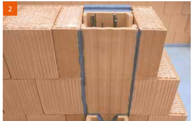
Verwendung als Stütze in Außenwand
