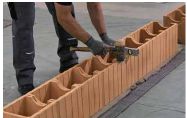
Lotrechtes Setzen der Schalungsziegel mit gespannter Richtschnur
