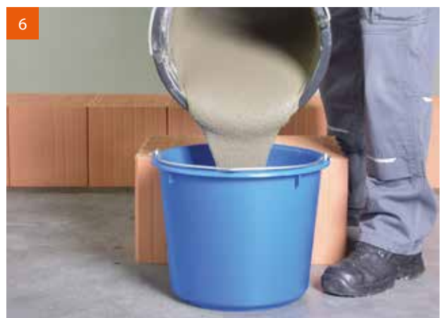
6 Dünnbettmörtel zur leichteren Handhabung erst in einen kleineren Eimer und anschließend in den Vorratsbehälter der Mörtelrolle/Walze füllen. Behälter der Mörtelrolle/Walze während der Verarbeitung nicht völlig entleeren.
