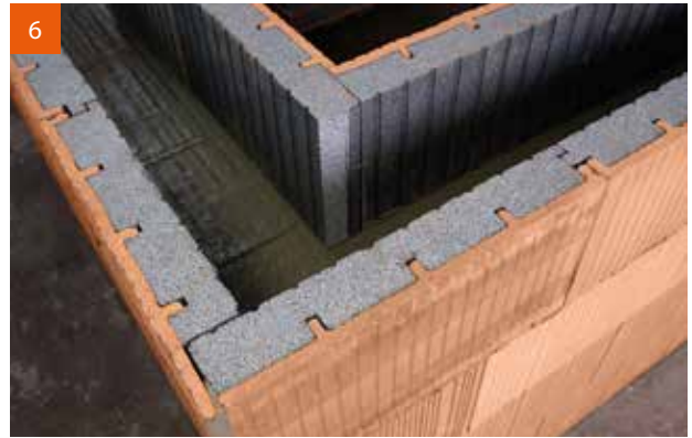
6 Fertige Ringbalkenschalung aus DS vario im Eckbereich.
