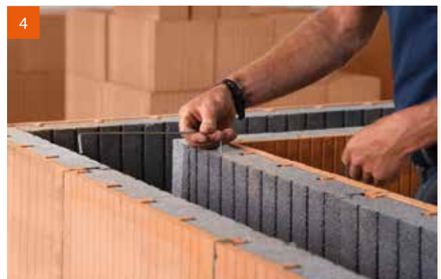
4 DS Vario Montagebügel zur Lagesicherung einsetzen.
