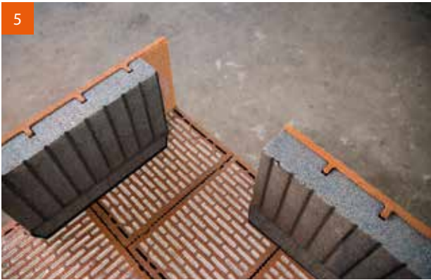
5 Ausklinkung im Eckbereich erstellen.
