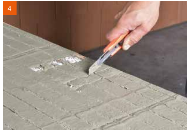
Bei der Verarbeitung mit V.Plus®-System kann auf das Raspeln verzichtet und dafür die Vertiefung durch Ausschneiden des Gewebes erstellt werden.
