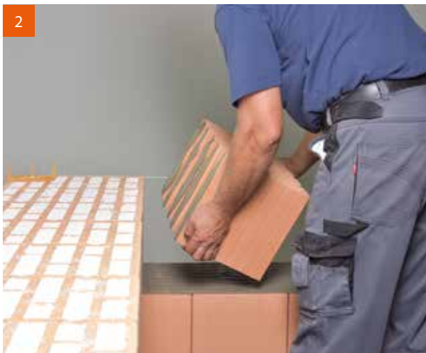
Setzen des Eckziegels.
