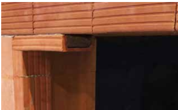
AnschlagSchale: Sturzuntersicht
