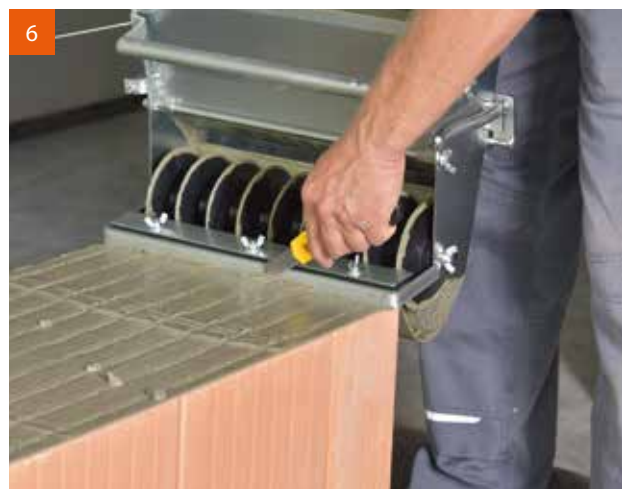
6 Abschneiden des V.Plus®-Glasfilamentgewebes mithilfe der Abschnittleiste und eines Teppichmessers.
