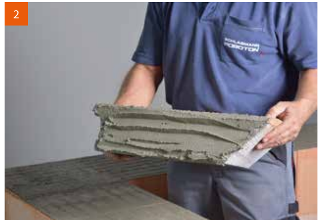
2 Satter Mörtelauftrag auf POROTON®-DRS®.
