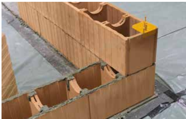
Mauern der Wanddecken im Verband
