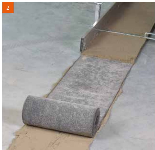
Einlegen einer Querschnittsabdichtung aus besandeter Bitumenbahn R 500.
