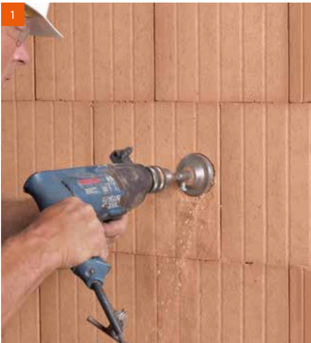
Erstellung der Aussparung für Unterputzdosen mit einer Bohrkrone.
