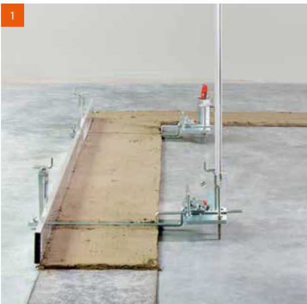
Anlegen der Ausgleichsschicht mit dem „Nivellier-Max“.
