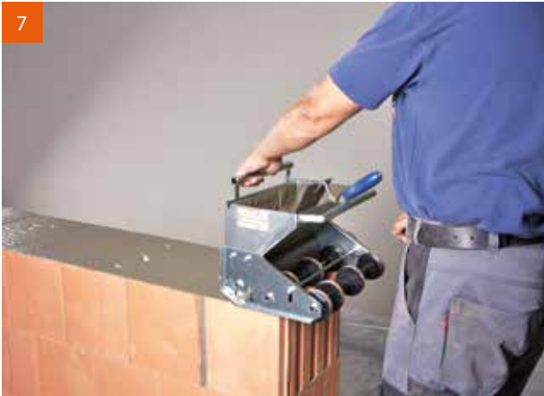
7 Mörtelrolle über das Mauerende hinausziehen.
