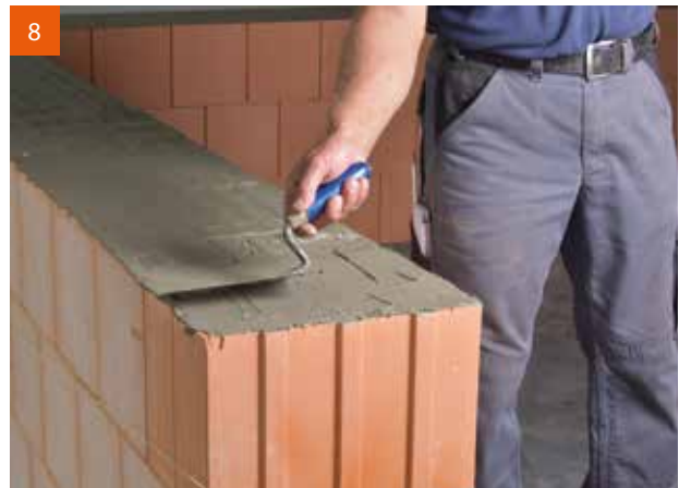
8 Am Mauerende mit der Kelle die Fehlstelle im Randbereich schließen.
