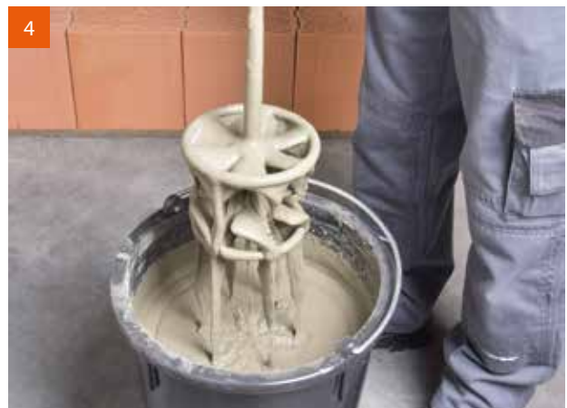
4 ... und Doppelrührquirl (z. B. Turbo-Mixer) klumpenfrei im Mörtelimer angerührt.
