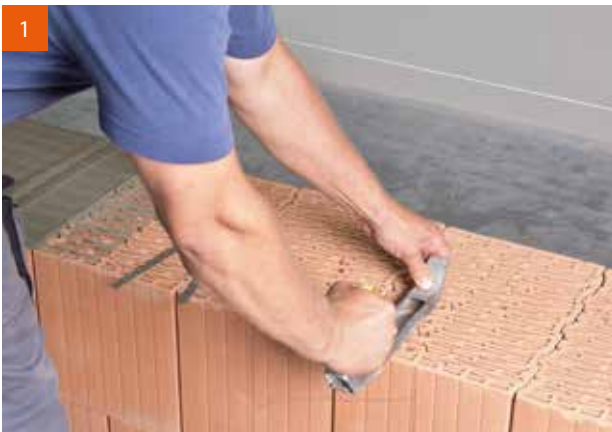
Um einen Höhenversatz zu vermeiden, wird vor dem Einsetzen der Flachstahlanker mit der Raspel eine leichte Vertiefung erstellt.
