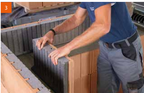
3 Setzen der Ringbalkenschalung.
