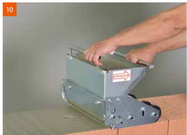
10 Die V.D-Mörtelrolle eignet sich für alle gefüllten, aber auch für Plan-Hochlochziegel ohne Füllung (z. B. U8, U9, T10, T12, T14).
