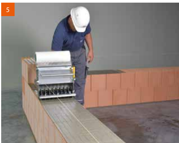
5 Walzen im Schritttempo und Versetzen gleichzeitig.
