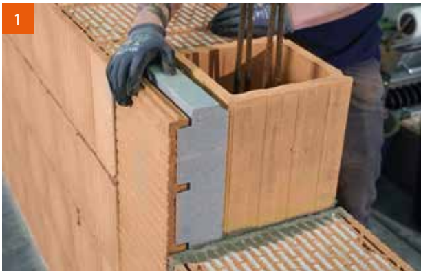
POROTON®-SDS® als Wandstütze
