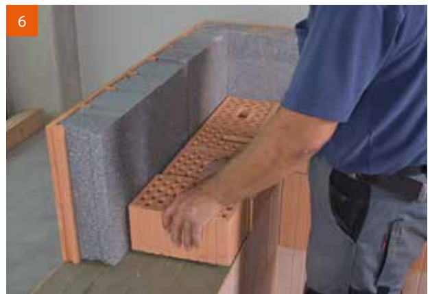
6 Setzen des kleinformatigen Ausgleichsziegels in das frische Mörtelbett. Alternativ: Verwendung des POROTON®-HAZ über die gesamte Wandstärke (siehe S. 29).
