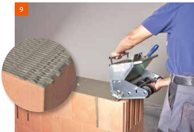
9 Alternativ kann am Mauerende die Rolle per Hand weitergedreht werden. In diesem Fall entsteht keine Fehlstelle im Randbereich.
