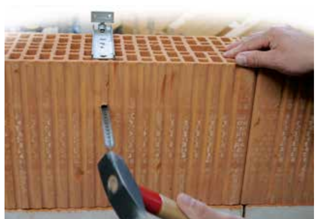
Fensterverschraubung im Brüstungsbereich mit V-Lochschiene
