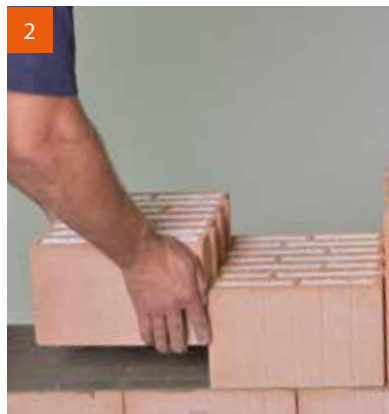
Versetzen des geschnittenen Ausgleichsziegels, z. B. im Bereich einer Fensterbrüstung.
