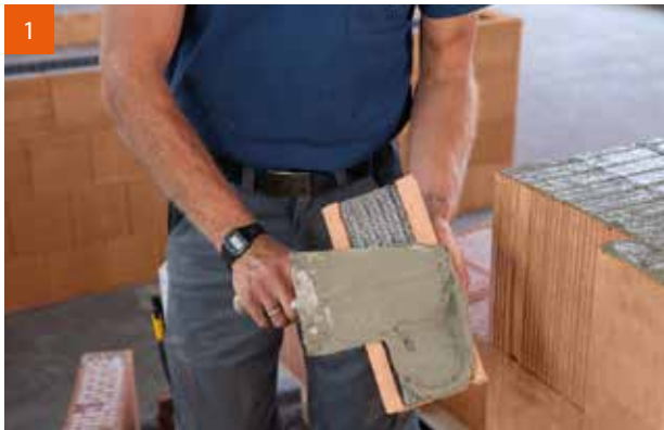
1 Satter Mörtelauftrag auf die Ziegelstege der AnschlagSchale.
