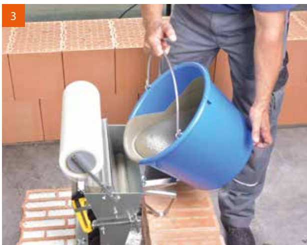
3 Befüllen der V.Plus®-Walze mit Dünnbettmörtel.
