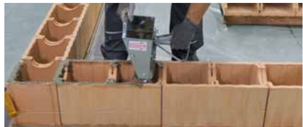
Auftrag von Dünnbettmörtel mit der Mörtelrolle
