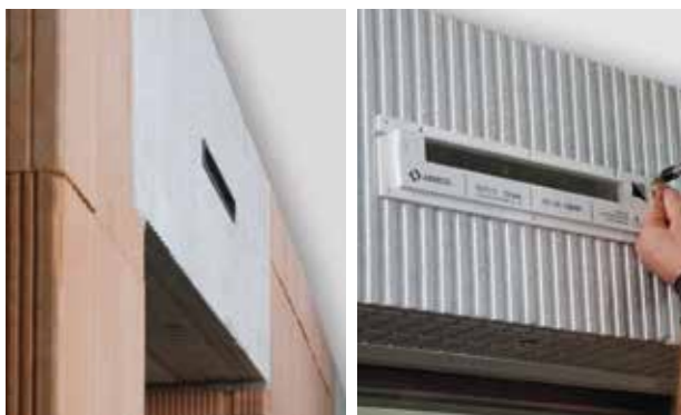
Im Kasten vormontierter Luftdurchlassschlitz
