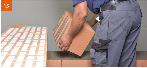
15 Versetzen des Eckanschlussziegels mit Mörtelauftrag auf der Verzahnung.
