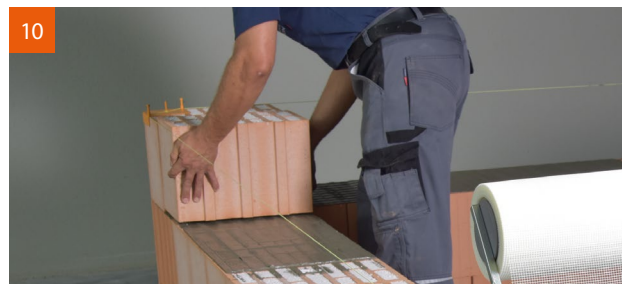
Einfaches knirsches Versetzen des Planziegels.
