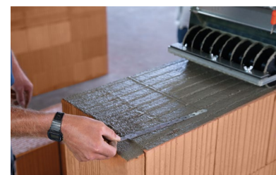
Ggf. zusätzliche Lagesicherung mit Flachstahllanker.
