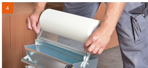
4. Einlegen des Gewebes in die V.Plus®-Walze.
