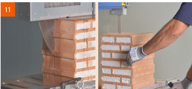
Ausgleichsziegel mit der Nass- oder Trockensäge schneiden.
