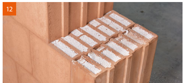
Der Ausgleichsziegel ist wärmebrückenfrei versetzt.
