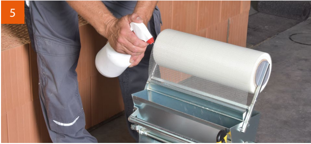
Die V.Plus®-Walze vor dem Befüllen mit Trennmittel (Schalöl) einsprühen. Das erleichtert die spätere Reinigung.
