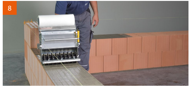
Walzen im Schritttempo und Versetzen gleichzeitig.
