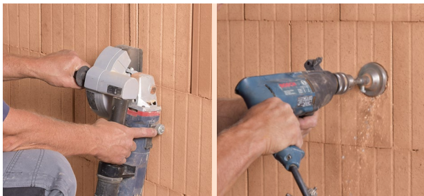
Schlitz und Kronenbohrung für Elektroboxen
