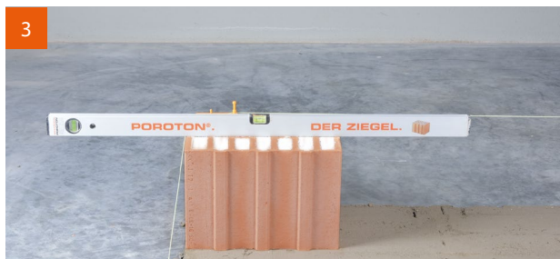
3. Lotgerechtes Setzen des ersten Ziegels mit gespannter Richtschnur. Legen der ersten Schicht.
