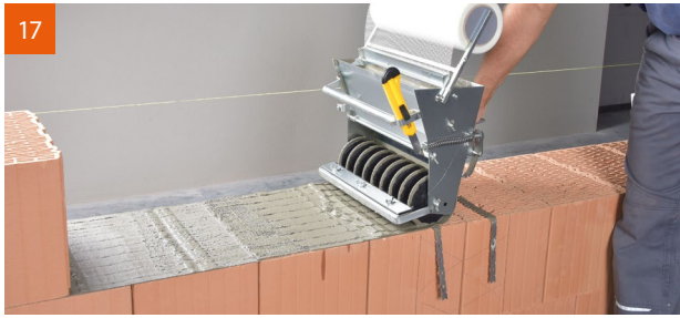
17 Anschließend wird der Mörtel über die Flachstahlanker gerollt.
