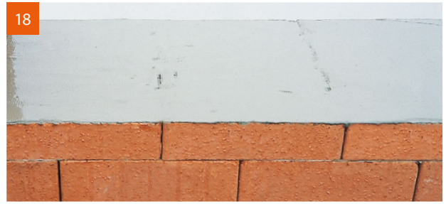
18 Die Fensterbrüstung wird mit V.Plus®-Deckelung vor Regen und Schnee geschützt.
