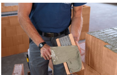
Anmörteln der Anschlagsschale.
