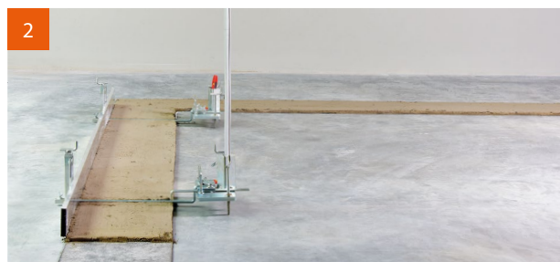
2. Anlegen des Mörtelbettes mit dem „Nivellier-Max“.
