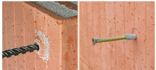
Bohren und Dübeln: Drehbohren OHNE Schlag- und Hammerwerk!
