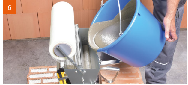
Befüllen der V.Plus®-Walze mit Dünnbettmörtel.
