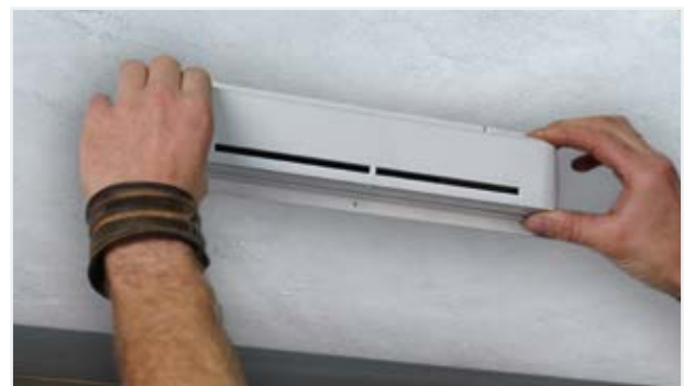
Von Aereco: Feuchtegeführter Außenbauteil-Luftdurchlass ZUROH 100 / 110 als Nachströmelement für Abluftanlagen, Montage nach dem Verputzen
