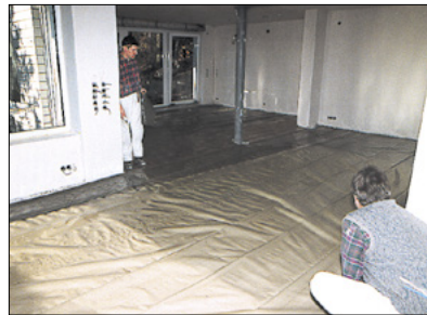
2 Einbau einer Abdecklage bei Verwendung von Fließestrichen.
