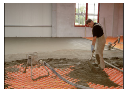
6 Druckprobe – Vor dem Einbringen des Estrichs ist eine Druckprüfung durchzuführen (siehe Druckprobenprotokoll, technisches Handbuch). Der Einbau des Estrichmörtels erfolgt ohne Bewehrung und ohne Bewegungsfugen (Estrichgüte CT-C25-F4, max. F5). Ausnahme: im Türbereich, mit Kellenschnitt oder Dehnfugenprofil Schlüter®-DILEX-DFP sowie bei Bauwerkstrennfugen.
