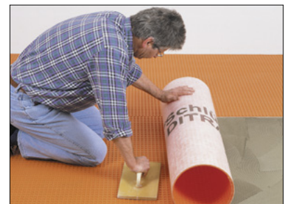
9 Verlegung der Entkopplungsmatte Schlüter®-DITRA 25 (in Verbindung mit Keramik- und Natursteinbelägen) in frischem Dünnbettmörtel nach Begehrbarkeit des Estrichs. Bei Calciumsulfatestrich nach einer Restfeuchte von \leq 2\% .
