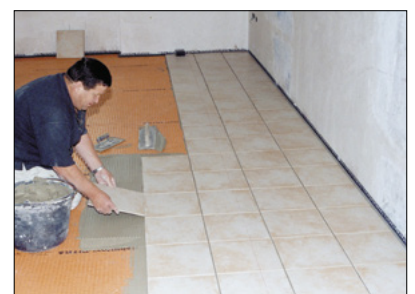
12 Verlegung des Fliesenbelags auf Schlüter®-DITRA 25 in Dünnbettmörtel.
