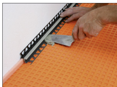
11 Einbau des Randbewegungsfugenprofils Schlüter®-DILEX-EK bzw. -RF.
