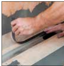
zu 1. Beim Wandebau: Abdeckstreifen zur Wand hin aufkleben
