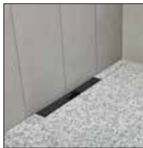
zu 3. Belag der Duschkfläche anarbeiten
