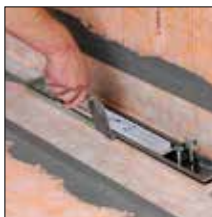
zu 3. Rahmen unterfüttern/ Fliesen vollflächig verlegen
