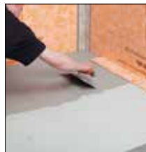
zu 6. Dünnbettmörtel auftragen
