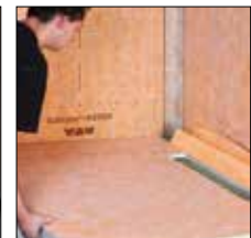
zu 3. Gefälleboard unter den Rand des Rinnenkörpers schieben
