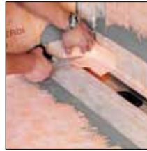
zu 2. KERDI-Manschette verkleben/ KERECK-Innenecke zuschneiden
