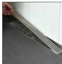
zu 4. Abdeckung einsetzen
