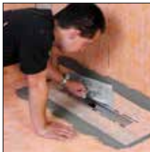
zu 4. KERDI-Manschette mit KERDI-COLL-L aufkleben
