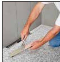
zu 5. Belagträger mit Dünnbettmörtel versehen
