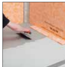
zu 7. Dünnbettmörtel auftragen
