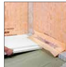
zu 3. Ausgleichsboard ebenflächig verlegen
