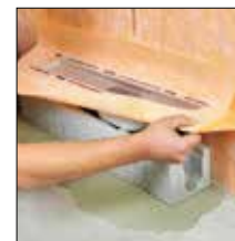
zu 2. Rinnenkörper einsetzen
