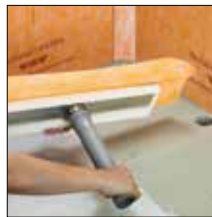
zu 2. Abflussrohr einsetzen
