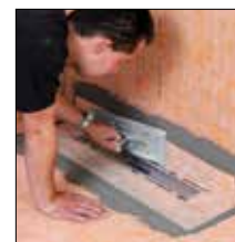
zu 4. KERDI-Manschette mit KERDI-COLL-L aufkleben
