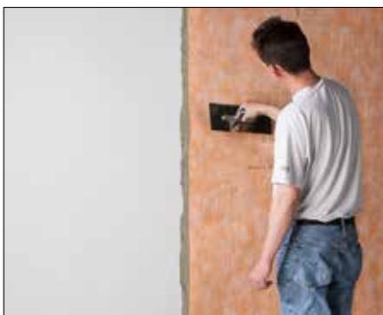
**2** Verwenden Sie zum Aufkleben der Bahnen einen Dünnbettmörtel (Fliesenkleber), der für den Untergrund geeignet ist. In der Regel ist dies ein handelsüblicher, hydraulisch abbindender Dünnbettmörtel. Tragen Sie diesen in entsprechender Breite mit einer Zahnkelle 4 x 4 mm vollflächig auf den Untergrund auf.
