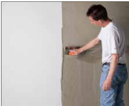
**1** Die Fläche, die abgedichtet werden soll, muss sauber, eben und tragfähig sein. Schneiden Sie Schlüter-KERDI mit einer Schere oder einem Teppichmesser auf die benötigten Maße zu.
