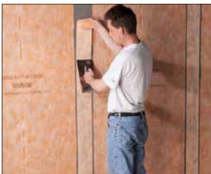
**3** Verkleben Sie die Schlüter-KERDI Bahnen mindestens 5 cm überlappend miteinander. Alternativ dazu können die Bahnen stumpf gestoßen und mittig mit Schlüter-KERDI-KEBA in 12,5 cm Breite überklebt werden. Zur Verklebung der Stoßbereiche und Überlappungen verwenden Sie den Dichtkleber Schlüter-KERDI-COLL-L. Schlüter-KERDI-KEBA ist auch für spezielle Eckanschlüsse geeignet.
