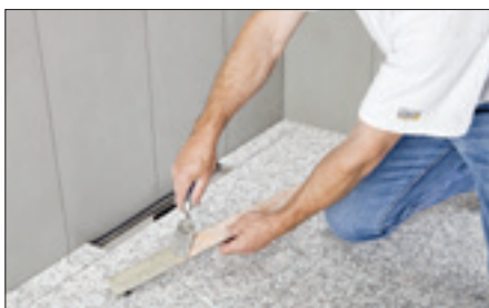
10 Belagträger mit Dünnbettmörtel versehen.
