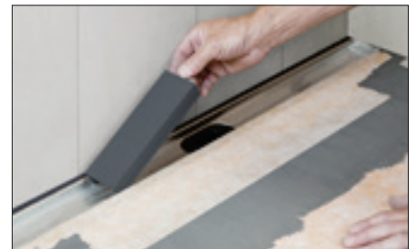
6 Distanzstücke in den Rinnenkörper einlegen und ...
