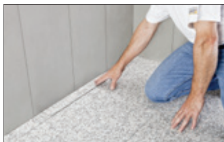
11 Belag aufkleben und ausrichten. Beim Verfugen ist der Bereich des Belagträgers auszusparen.
