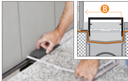
8 Beim Wandeinbau: Breite (B) des Belages entspricht dem lichten Abstand von der Wand bis zur Innenkante des Distanzstückes abzüglich 1 mm. Beim Mitteleinbau: Breite des Belages entspricht dem Innenmaß des Distanzstückes (= 50 mm).
