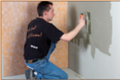
1 Dünnbettmörtel (Zahnung 3 x 3 mm) zur Verklebung der Verbundabdichtung Schlüter®-KERDI aufbringen.
