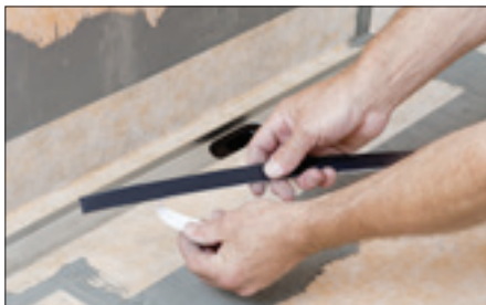
4 Beim Wandeinbau: Schutzfolie des Abdeckstreifens abziehen und ...
