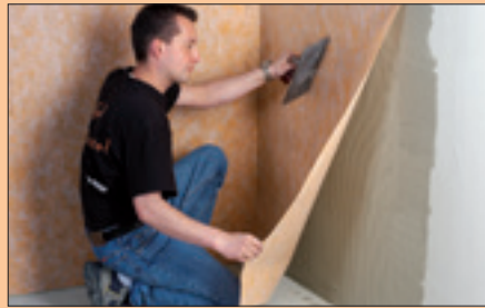
2 Schlüter®-KERDI Bahn aufbringen und glätten.
