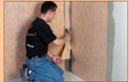
3 Im Stoßbereich mit Schlüter®-KERDI-KEBA Band unter Verwendung von Schlüter®-KERDI-COLL vollflächig überkleben.
