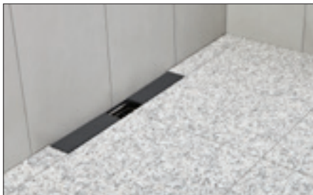
7 ... den Belag anarbeiten. Herausquellenden Dünnbettmörtel rückstandslos entfernen bzw. offene Bereiche in der Kleberschicht vollständig verschließen, siehe Hinweis.
