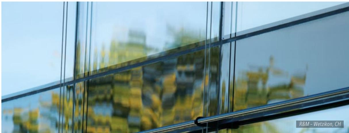
Die THERM<sup>+</sup> Structural Glazing SG2-Fassaden bieten die filigranste Verglasungstechnik. Nur eine schmale Silikonfuge bleibt zwischen den Isolierglasscheiben sichtbar. Die Fixierung der Innenscheibe erfolgt einfach, schnell und sicher durch spezielle eindrehbare SG-Glashalter. Durch das Dämmsystem mit Dämmblock SG erreichen die Fassaden dabei hervorragende Wärmedämmwerte.
