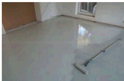
2. Auftrag der Versiegelung
