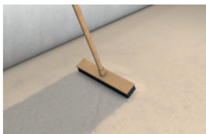
1. Grundierung reinigen, losen Quarzsand entfernen
