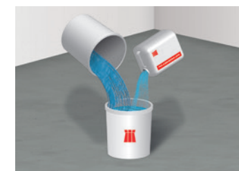
6 Verdünnung von ASO-Unigrund-K je nach Saugfähigkeit des Untergrundes
