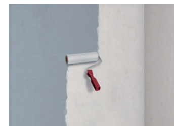
7 Grundierung des Wanduntergrundes
