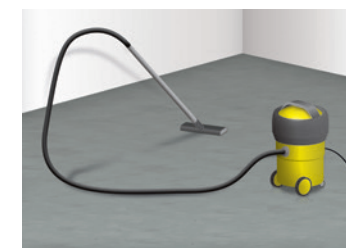
4 Reinigen des Bodenuntergrundes
