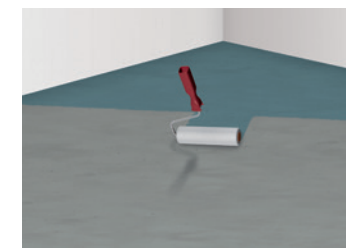
8 Grundierung des Bodenuntergrundes
