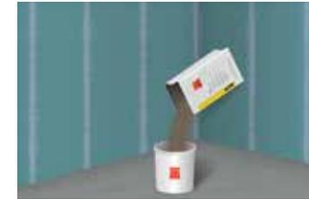
3 Einfüllen des Klebemörtels in ein sauberes Anmischgefäß
