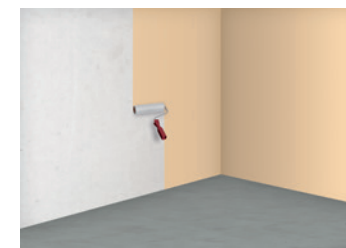
7 Auftragen der Grundierung an der Wand
