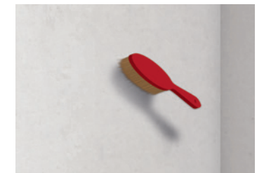
2 Reinigen des Wanduntergrundes
