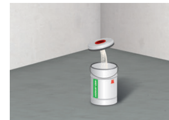
5 Vollständiges Entleeren der Härter- in die Harzkomp.
