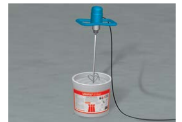
4 Anmischen des Klebemörtels
