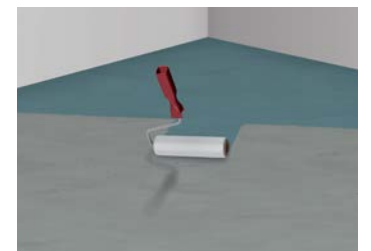
2 Grundieren des Untergrundes, z.B. mit ASO-Unigrund
