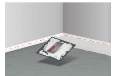
8 Auftragen einer Kontaktschicht bei größeren Formaten
