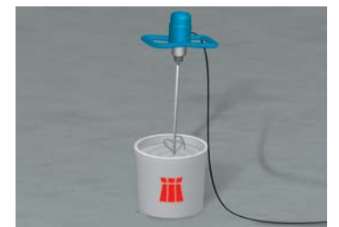
4 Anmischen des Klebemörtels
