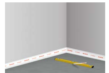
6 Einteilen der Bodenfläche
