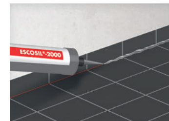
3 Einbau von ESCOSIL-2000
