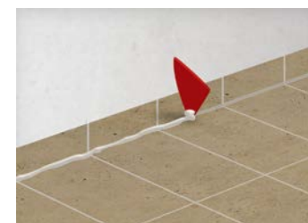
5 Abziehen des überschüssigen Silikondichtstoffes
