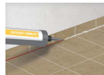
3 Einbau von ESCOSIL-2000-ST
