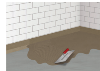
7 Auftrag der 1. Abdichtungsschicht
