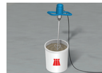
5 Anmischen der Abdichtung
