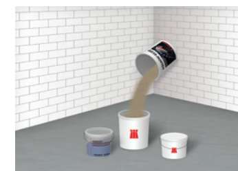
4 Einfüllen der Abdichtung im vorgegebenen Mischungsverhältnis
