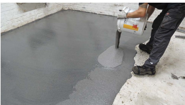
Praxisbeispiel Aufbringen einer fließfähigen Ausgleichsschicht auf Beton
