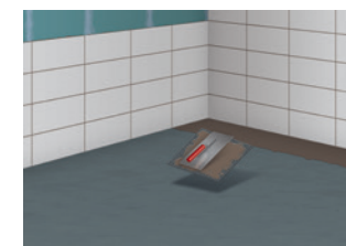
11 Auftragen einer Kontaktschicht bei größeren Formaten
