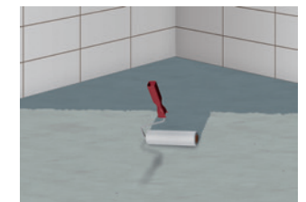
8 Grundieren des Untergrundes, z.B. mit ASO-Unigrund
