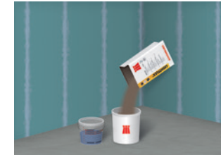
3 Einfüllen des Klebemörtels in einen sauberen Mischeimer
