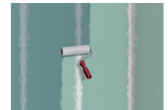
2 Grundieren des Untergrundes, z.B. mit ASO-Unigrund
