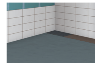
12 Verlegen der Bodenkeramik
