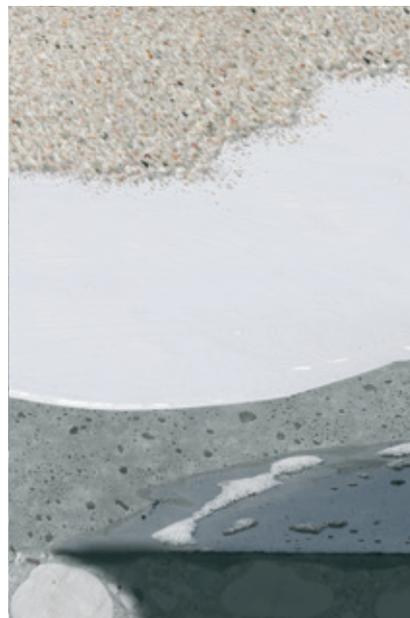
Durch gezielte Reinigung mit unserem Spezialreiniger ASO-R008 können hartnäckige Verschmutzungen, z.B. durch Öl, beseitigt werden. Um weitere Ölverschmutzungen oder aufsteigende Feuchtigkeit fernzuhalten, erfolgt die Grundierung mit der hoch wasserdampfsperrenden Grundierung ASODUR-SG2.
