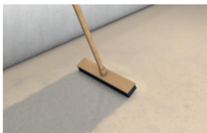
1. Grundierung reinigen, losen Quarzsand entfernen
