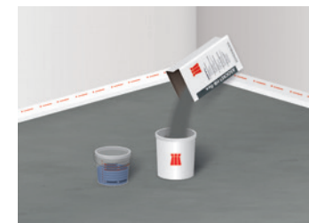
3 Anmischen der Haftschlämme in abgemessener Wasservorlage
