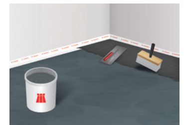
6 Auftragen der Haftschlämme auf angefeuchteten Untergrund
