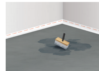
5 Anfeuchten des Untergrundes
