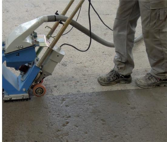
Die Abdichtungsstoffe müssen mit dem Untergrund harmonieren und benötigen optimale Haftung für eine sichere und lang anhaltende Dichtfunktion. Aus diesem Grund ist die Untergrundvorbehandlung mit seinen spezifischen Anforderungen in den Teilen 1 und 3 der DIN 18533 geregelt. In der Norm sind die Grundlagen und Details, wie z. B. die Ebenheit, Gratentfernung und Säuberung, für jeden Anwender bzw. Verarbeiter verbindlich festgeschrieben.
