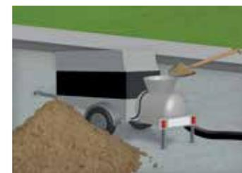
1 Einfüllen des Zuschlages in Estrichmischmaschine
