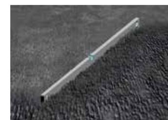
6 Abziehen des Estrichmörtels auf Höhe mit geeigneter Richtlatte
