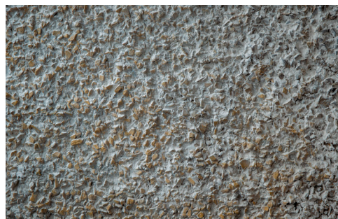
Durch Frost-Tau Bewitterung in Verbindung mit Taumitteln reduzierte Betonüberdeckung
