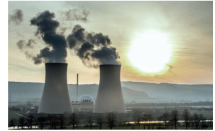
Kühltürme von Kraftwerksanlagen
