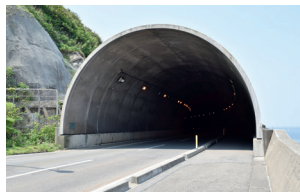
Tunnel und Betonrohre
