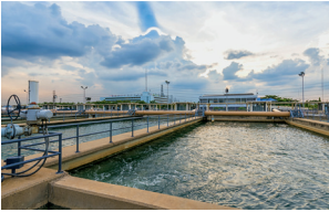
Auffang- und Rückhaltebecken
