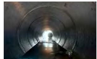
Kanal- und Schachtbauwerke
