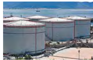
Tanks und Behälter
