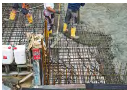
Betonierung auf AQUAFIN-WM12
