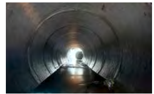
Kanal- und Schachtbauwerke
