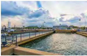
Auffang- und Rückhaltebecken
