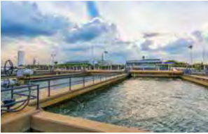
Auffang- und Rückhaltebecken
