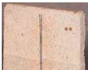
Verbund zweier AQUAFIN-CJ5 Bleche im Betonquerschnitt. Überlappungen sind einfach per Halteklammern herzustellen.
