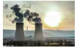
Kühltürme von Kraftwerksanlagen
