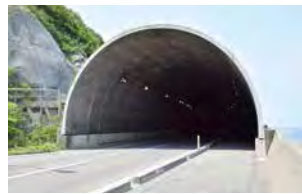
Tunnel und Betonrohre
