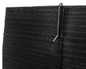
Verbund zweier AQUAFIN-CJ5 Bleche im Betonquerschnitt. Überlappungen sind einfach per Halteklammern herzustellen.
