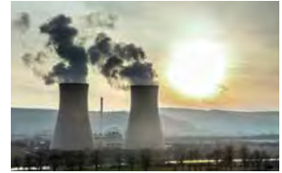
Kühltürme von Kraftwerksanlagen
