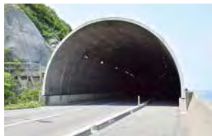
Tunnel und Betonrohre
