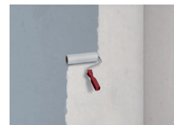
2 Grundieren des Untergrundes z.B. mit ASO-Grund
