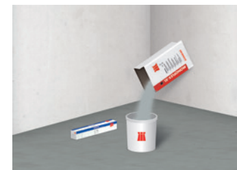
3 Einfüllen und anmischen von z.B. MONOFLEX-XL
