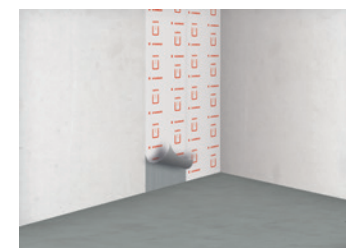
6 Verklebung der SANIFIN-Bahnen mit Überlappung
