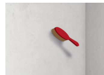
1 Reinigen des Untergrundes
