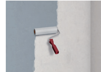
3 Grundieren des Untergrundes, z. B. mit ASO-Unigrund
