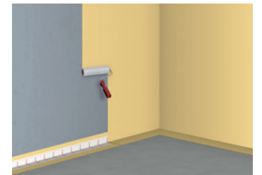
6 Auftrag der 1. Abdichtungsschicht
