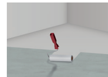
7 Auftragen der Grundierung auf dem Boden
