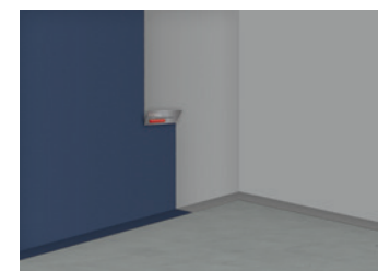
11 Auftrag der 2. Abdichtungsschicht (Einstreuschicht)
