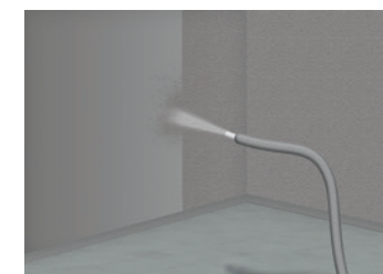
12 Vollflächiges Abstreuen mit Quarzsand in die frische Einstreuschicht
