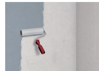
3 Grundieren des Untergrundes mit z. B. ASODUR-SG3-thix
