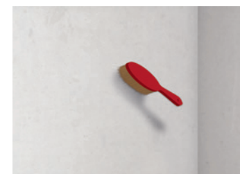
1 Reinigen des Untergrundes
