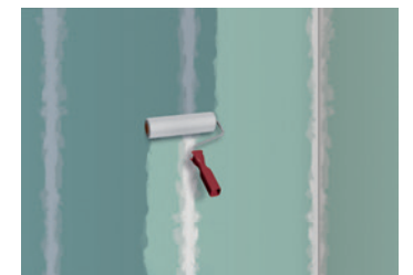
2 Grundierung des Wanduntergrundes
