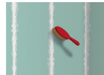
1 Reinigen des Wanduntergrundes
