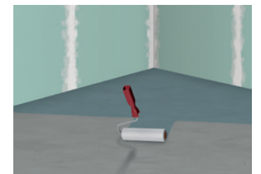
4 Grundieren des Bodenuntergrundes
