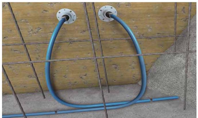
Durch die einfache Befestigungsart lassen sich auch schwierige Fugenverläufe anpassen. Bei Kontakt mit Wasser reagiert das enthaltene thermoplastische Elastomer und führt zu einer Volumengrößervergrößerung. Durch den resultierenden Anpressdruck dichtet das Material anschließend die Arbeitsfuge gegen die umliegenden Betonflanken ab.
