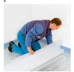
1 Installation der Wärme-/ Kühlleitlamellen (998 x 122 x 0,4 mm) mit vorgestanzter Sollbruchnut in die Rillenkontur des Trockenbau-Elementes.
