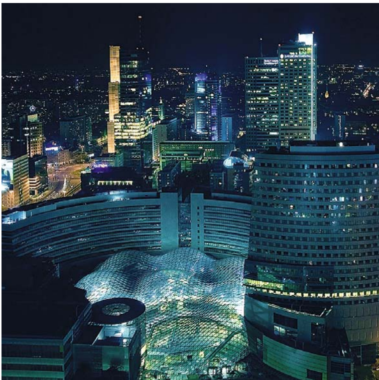
Beispiel für gelungene Gebäudeautomation mit Oventrop Komponenten und Systemen: „Goldene Terrasse und Rondo 1“ in Warschau, Polen
