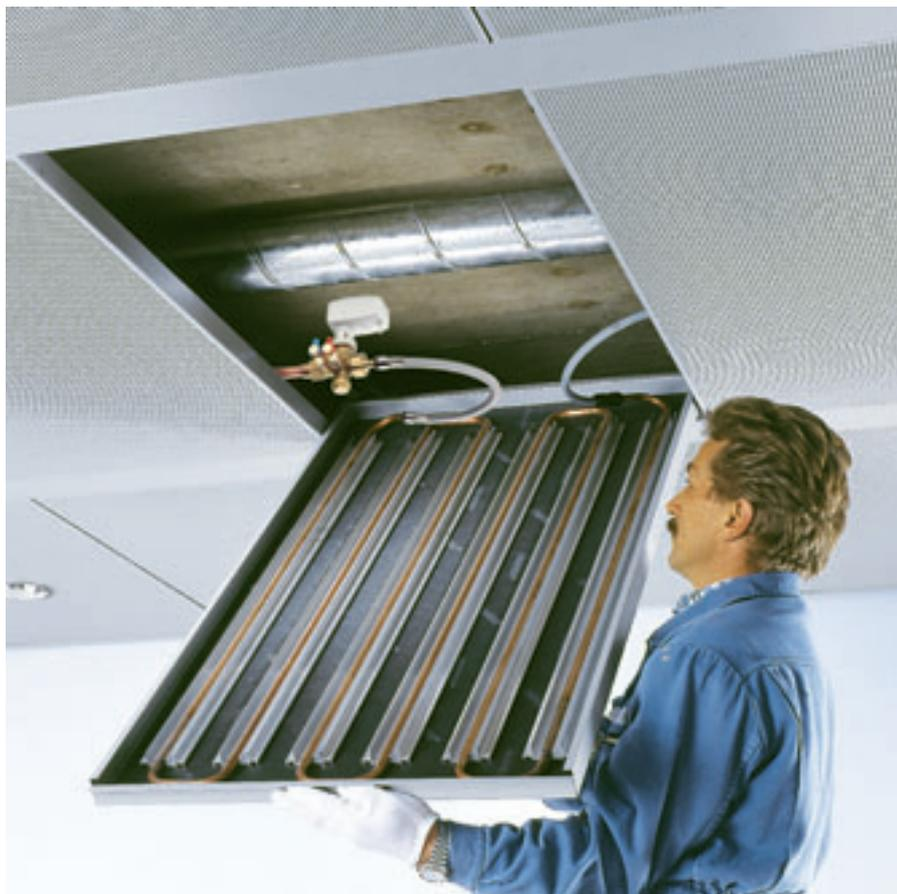
Im Bereich der Raumluftkühlung von Bürogebäuden nehmen Kühldeckensysteme einen stetig wachsenden Anteil ein, wobei diese Systeme unter Beachtung einiger Randbedingungen auch zum Heizen eingesetzt werden können.
