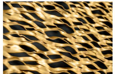
Mehr Gestaltungsfreiheit für geöffnete Fassaden mit hohem Brandschutz, z. B. Stamisol Safe One kombiniert mit Streckmetall gold eloxiert
