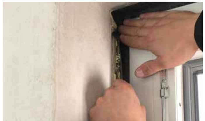
Bild 8: Ausbildung eines luftdichten Anschlusses im Eckbereich Sturz zu Laibung
