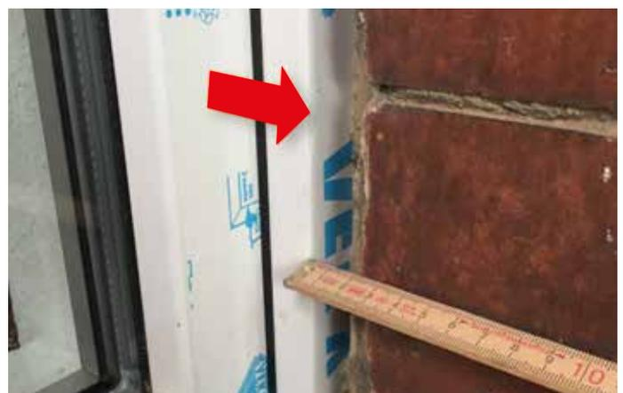
Bild 6: Fehlender Wetterschutz im Bereich der Laibung
