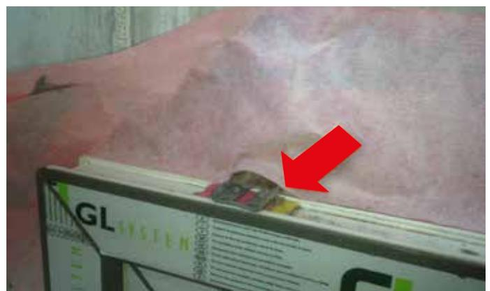
Bild 4: Unzureichend abgedichtete Durchdringung der Luftdichtheitsebene
