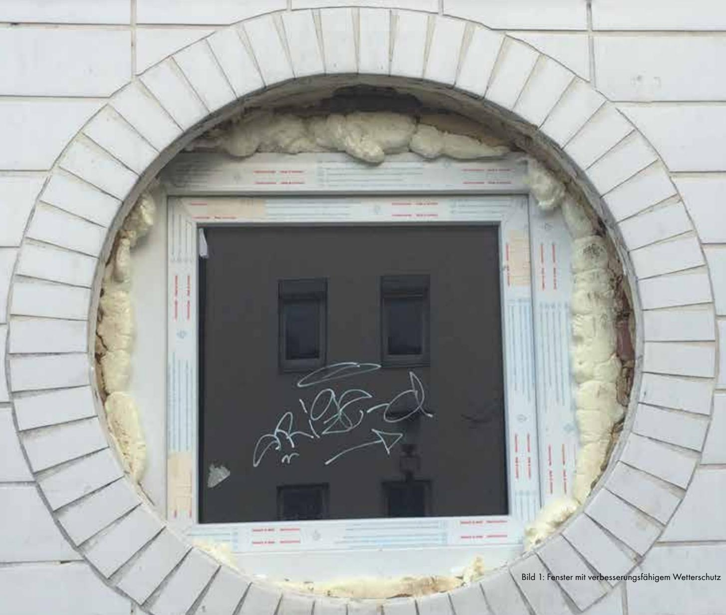
Bild 1: Fenster mit verbesserungsfähigem Wetterschutz
