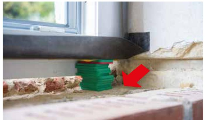
Bild 3: Mangelhaft vorbereiteter Untergrund im Bereich der Brüstung
