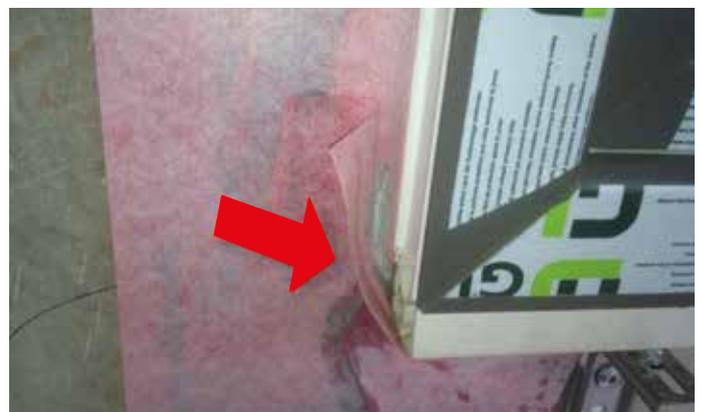
Bild 5: Abgelöste Folienabdichtung im Bereich eines Bankanschlussprofils
