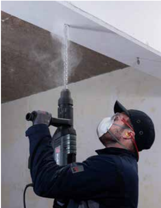
Montageanleitung – Stufenbohrung Herstellung
