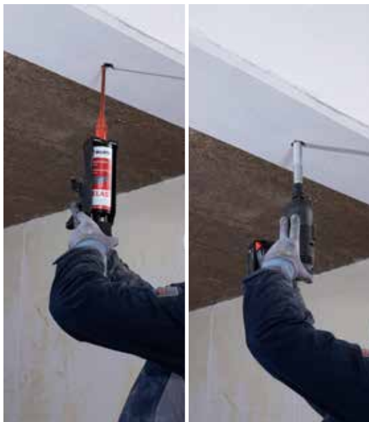
Montageanleitung – Injektion und Eindrehen ins Bohrloch
