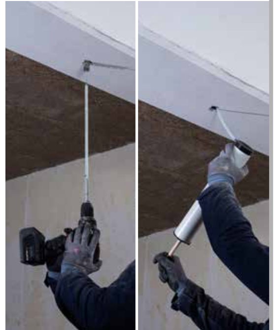
Montageanleitung – Stufenbohrung Reinigung
