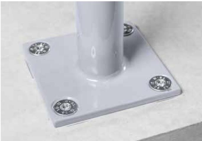
Besonders für Geländer und Handläufe eignen sich Befestigungen, die bündig mit der Ankerplatte abschließen.
