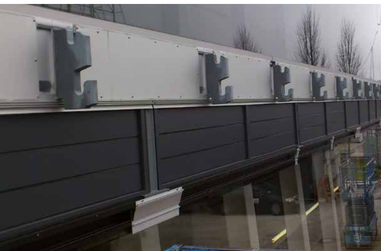
Prüfbau: Zuluftelemente planungsgemäß später oberhalb der Verglasung unsichtbar integriert
