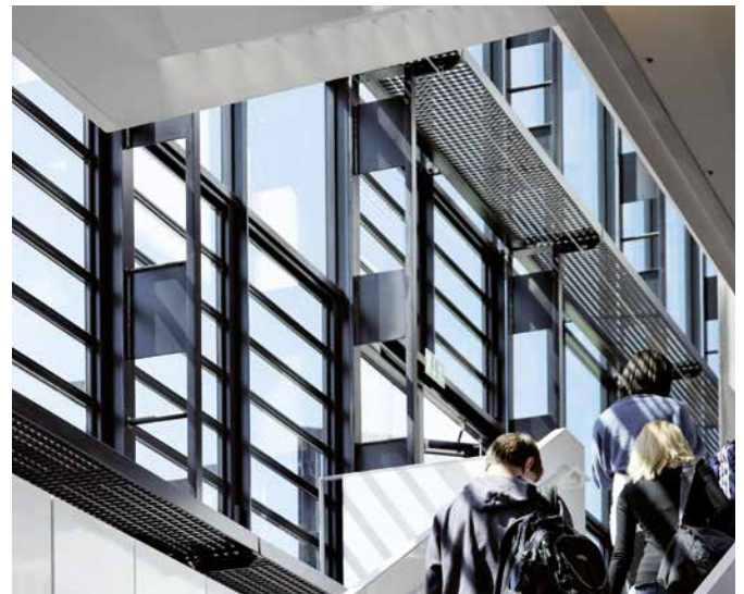
Deutschhaus-Gymnasium Würzburg, Wulf Architekten: Die verglaste Treppenhalle bringt das Licht bis in das Erdgeschoss. Die verbauten Lamellenfenster in der Fassade sorgen für die tägliche Lüftung und dienen zur Rauchableitung im Brandfall.
