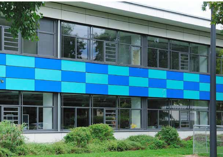
Geschwister-Scholl-Schule: Einsatz zur natürlichen Belüftung in Klassenzimmern
