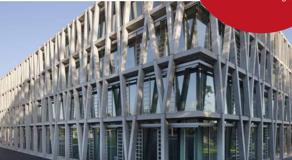
Cycle d'orientation de Drize, Genève: Ein Wechsel der geschosshohen Lamellenfestern und Festverglasung zeichnen die Fassade aus. Die Lamellenfenster sorgen automatisiert für den natürlichen Luftaustausch in der Schule.
