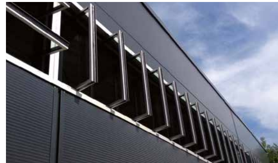
Produktion, Birkenau: Einsatz in Sandwich-Platten. Besonderheit: Kombination von vertikal und horizontal drehenden Lamellen
